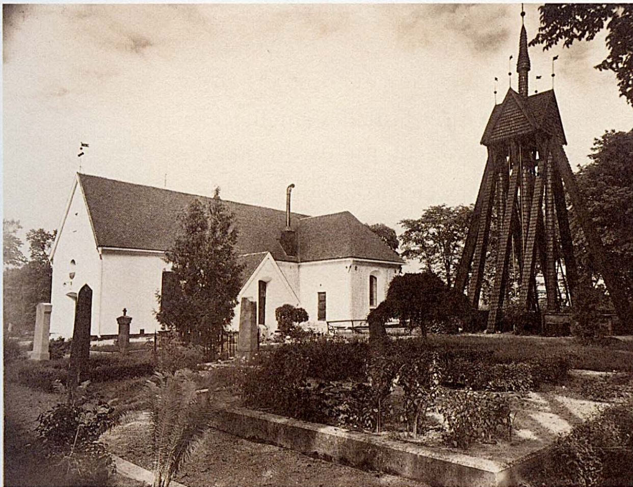
ALLMÄNNA BRANDFÖRSÄKRINGSFONDENS FÖRSTA FÖRSÄKRING KOM ATT GÄLLA ALMBY KYRKA I ÖREBRO. DEN TECKNADES 1782, SAMMA ÅR SOM FONDEN GRUNDADES. FÖRSÄKRINGEN GÄLLER ÄN I DAG.
